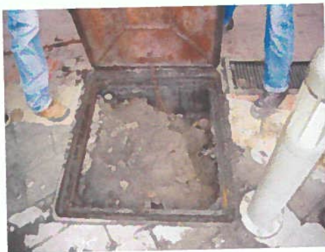
Gráfico 4. Caja eléctrica con tierra
