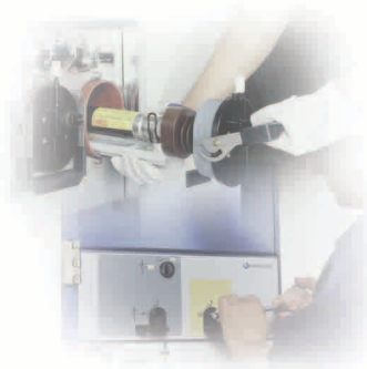
Instalación de fusible y maniobras
