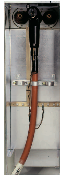
Detalle conexión. Borna en T EUROMOLD (K-400TB) atornillable
