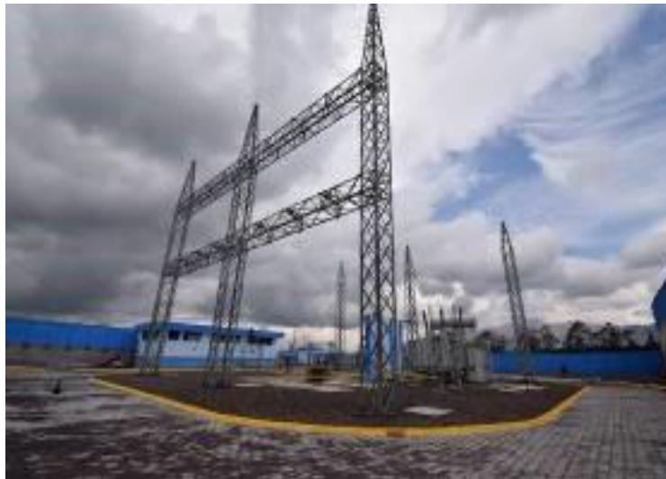
Ilustración 11. Construcción de la Subestación Eléctrica Mirador Alto
