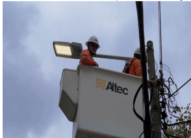
Ilustración 4. Cambio de luminarias de vapor de sodio a Tecnología LED
