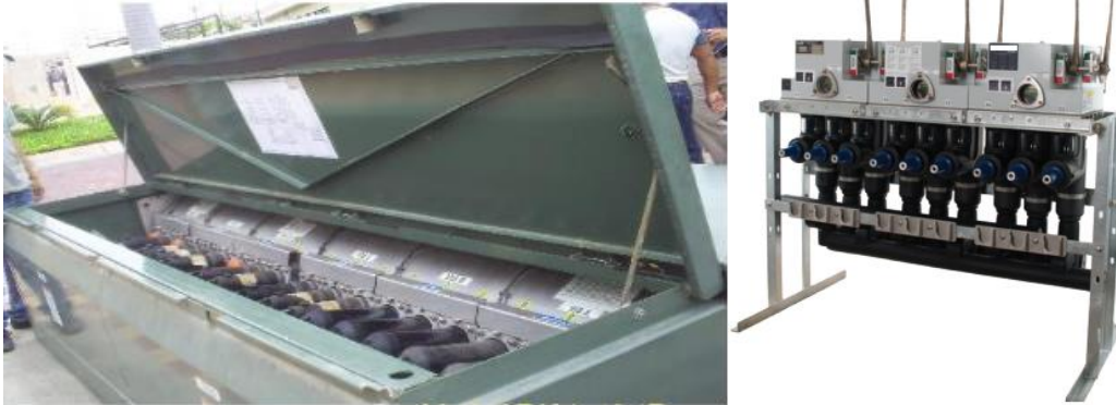
Fig. A-15.04_ 8 Equipo de protección y seccionamiento para redes subterráneas aislado en estado sólido.
