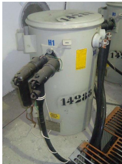
Fig. A-15.04_5 Transformador convencional de frente muerto (monofásico).
