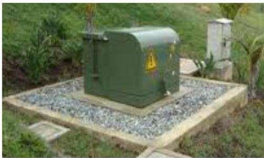
Fig. A-15.04_ 2 Instalación del transformador pedestal.
